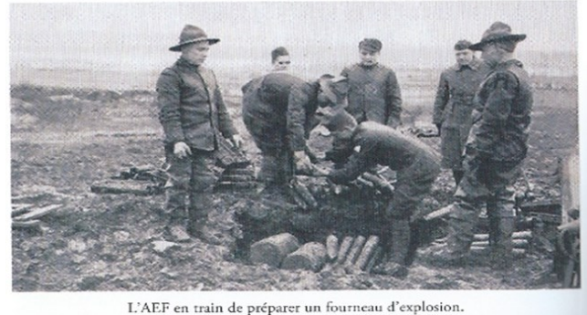
L'AEF en train de préparer un fourneau d'explosion.
